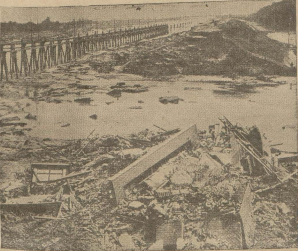
Geçen hafta meydana, şiddetli bir tuğyan neticesinde, meşhur Albert kanalının sederi yıkılmış ve su etrafa yayılmıştır. Su tazyiki o kadar kuvvetli olmuştur ki, resim - de gördüğünüz gibi kanal etrafındaki bazı binalar tamamen harab olmuş ve ancak izleri kalmıştır.
